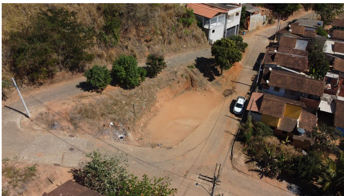
Figura 2 – Vista Lateral, mostrando o corte de talude já existente.
